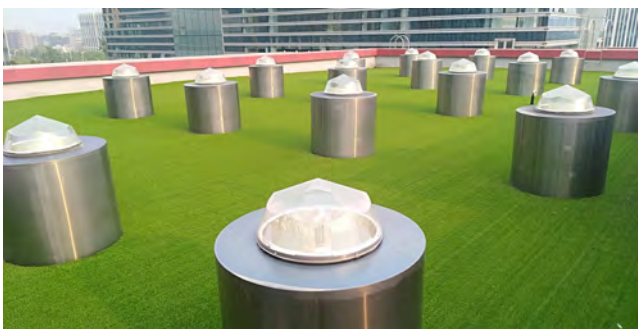
图3 屋顶导光管示意图
