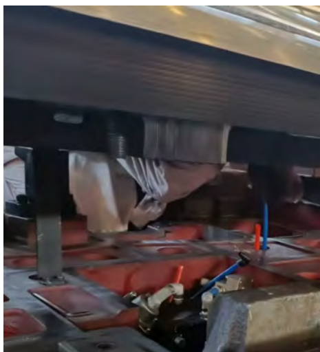
图四、下模镶块起吊时连接气管
